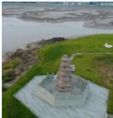
维修后的新安澜塔塔
